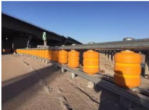
**FIG NO.03 COLLISION RESISTANT ROLLERS**
